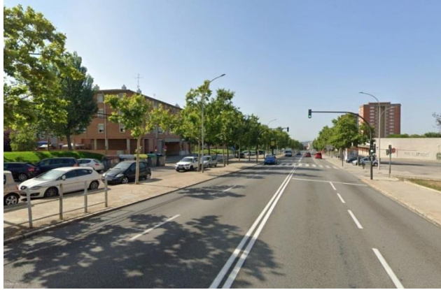
Imatge 50. Carretera de Matadepera. Tram 1. Font: Google Earth
