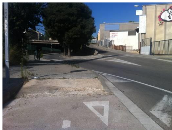
Arreglar la rampa
